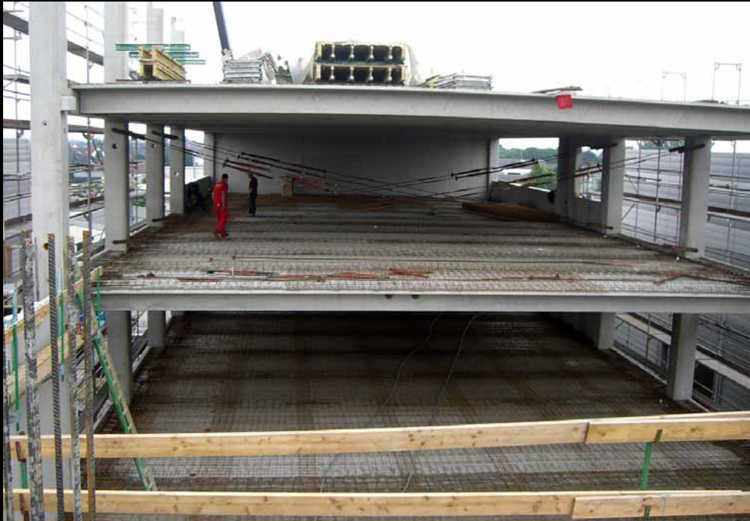
Neubau Bürogebäude Eitle
