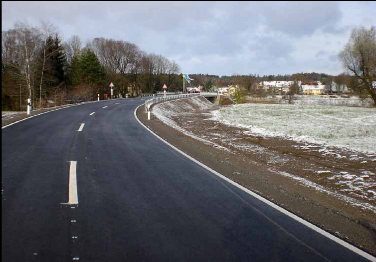
Brücke über die Schussen K7981
